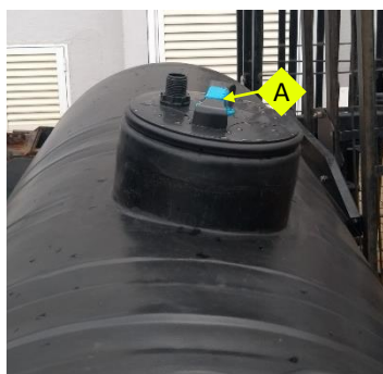
Respiro está localizado na tampa dos reservatórios
