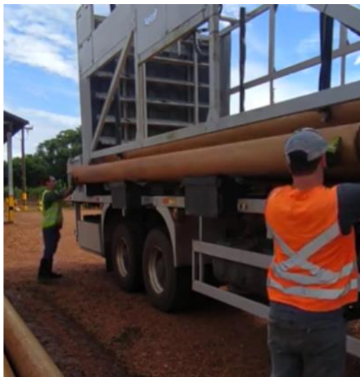
Fig.5.12: Carregamento de tubos
